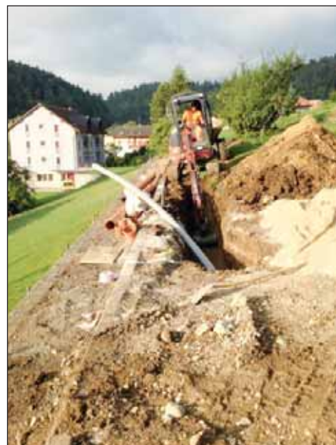
Travaux en dessous du Collège
