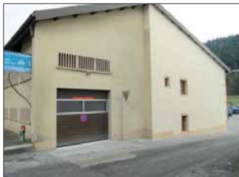
Façade côté « ruelle du garage »
