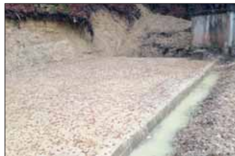
Travaux d'étanchéité du réservoir
