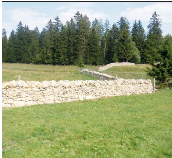
Mur Maisons Doubles-Brégnette, réfection 2012 (89 m)
