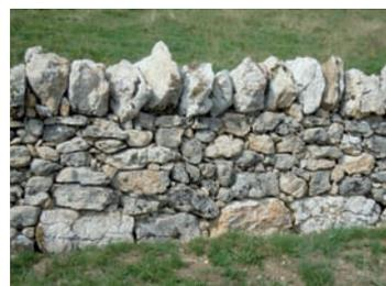
Des pierres de liaison appelées «bottisses ou parpaings» sont disposées à différents endroits, en traversant toute l'épaisseur du mur. Les couvertes disposées verticalement ou en oblique assurent la cohésion par leur poids.
