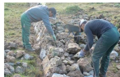
Montage : les pierres sont disposées en quinconce par rapport à la couche supérieure. A l'intérieur du mur les petites pierres sont disposées soigneusement et non versées en vrac. (pas de gravier, chaille ou terre)
