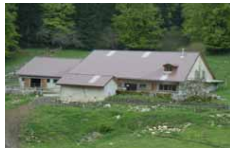
Sagnette après les travaux
