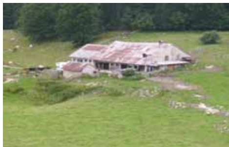
Sagnette avant les travaux
