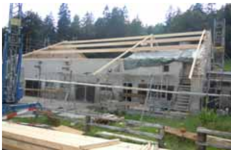
Sagnette pendant les travaux
