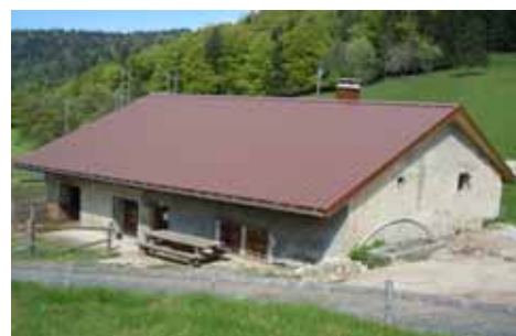
Suchaud après les travaux
