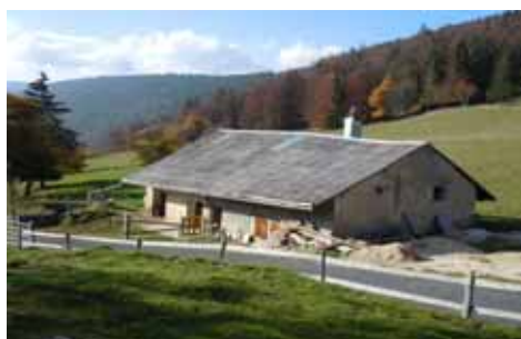
Suchaud avant les travaux
