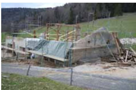
Suchaud pendant les travaux
