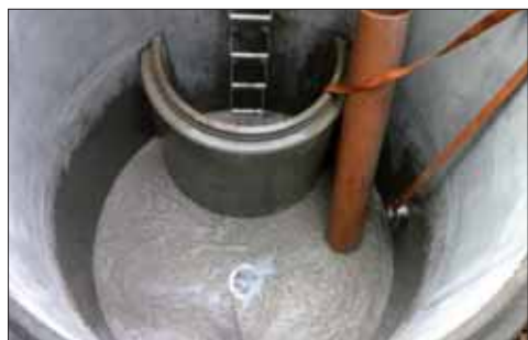
Aménagement de la chambre de captage
