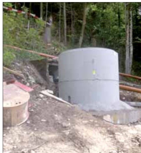
Construction du nouveau puits devant l'ancien puits
