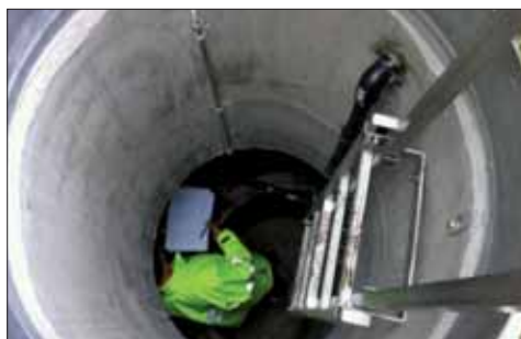
Puits d'accès à la chambre de captage
