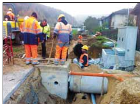
Les travaux de la parcelle 91 avec notamment le raccordement au canal du Roche
