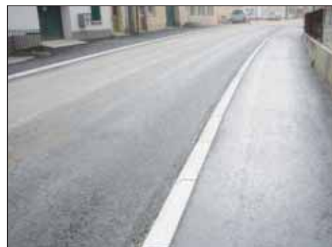
La Grand-Rue en enrobé bitumineux en attendant le tapis de finition
