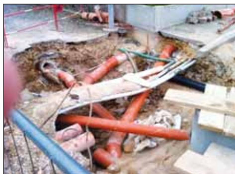
La Grand-Rue en travaux avec quelques «nœuds» assez compliqués
